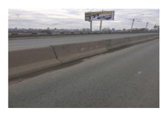
Рис. 2. Дорожное парапетное ограждение типа «Нью-Джерси» на Коммунальном мосту г. Новосибирска
