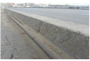
Рис. 3. Отслаивание верхнего слоя цементобетонного покрытия от поверхности ограждения на Коммунальном мосту г. Новосибирска
