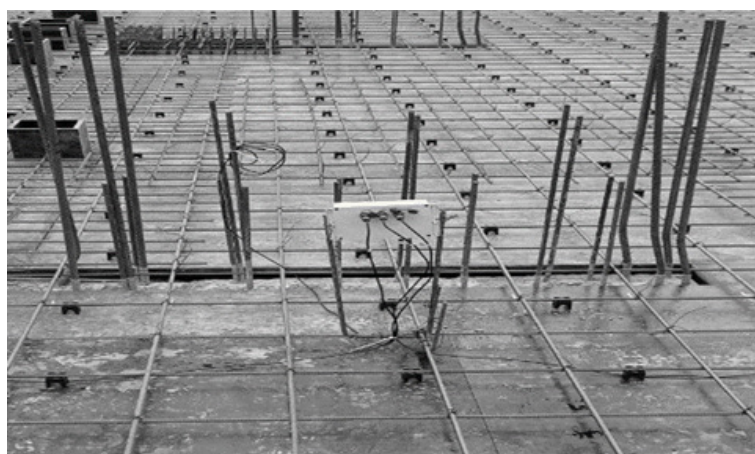
Рис. 2. Установка системы термомониторинга в плите перекрытия
