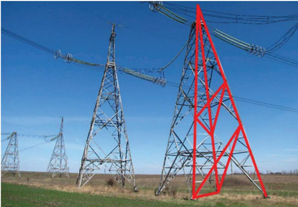
Рис. 3. Конфигурация Дезарга в металлической опоре ЛЭП
